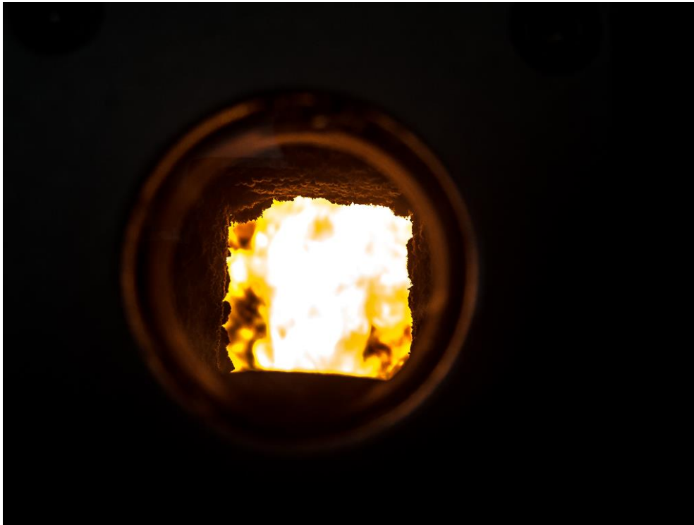
Guckloch in die Hauptverbrennungskammer
